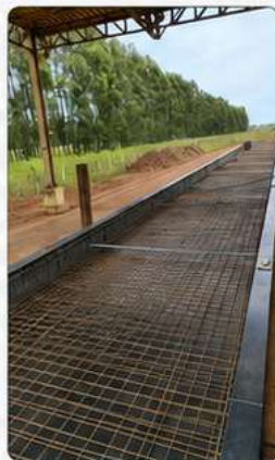
Formas, escoramento e armação
