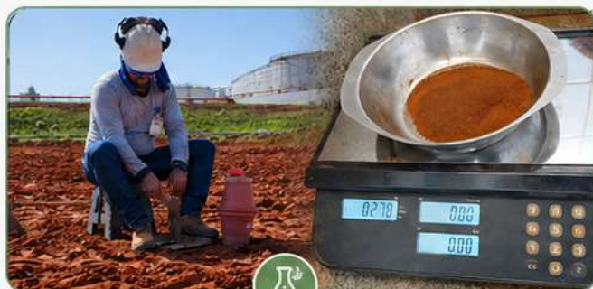
Terraplenagem e controle do solo Ensaio in situ e controle de umidade
